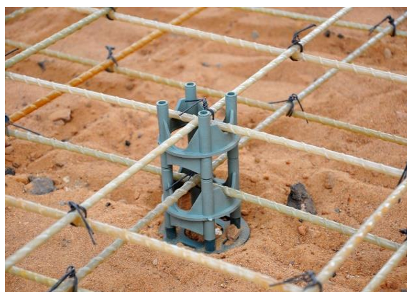
Рис. 3.9. Фиксаторы защитного слоя
