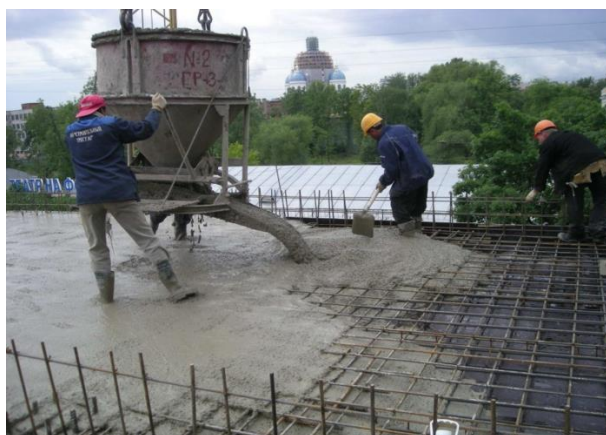
Рис. 5.3. Переносные бункера (бад'и): а – поворотные; б – неповоротные (вертикальные)
