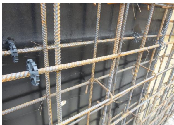
Рис. 3.9. Фиксаторы защитного слоя
